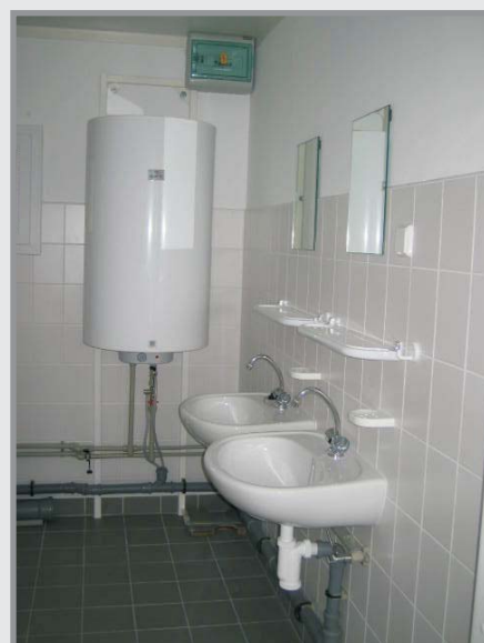
Umyvadlo, stojatá baterie, zrcadlo, polička, mýdelník, háček na ručník, boiler 120 l, rozvody a odpady vedené po stěnách
