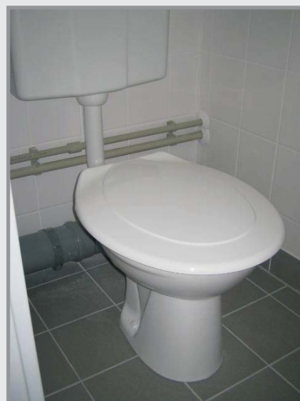
WC se splachovací nádr'kou, plastové rozvody vedené po stěnách, obklady, dlat'ba
