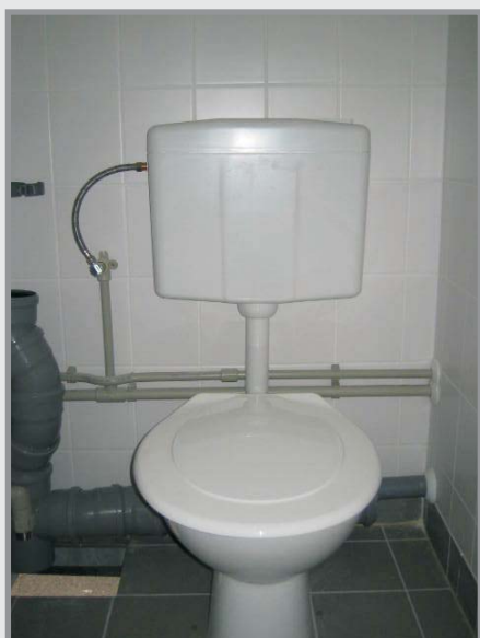
WC se splachovací nádr'kou, plastové rozvody vedené po stěnách, obklady, dlat'ba
