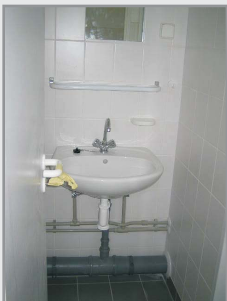
Umyvadlo, stojatá baterie, zrcadlo, polička, mýdelník, háček na ručník, boiler 120 l, rozvody a odpady vedené po stěnách
